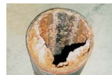
Как избежать закупорки труб
