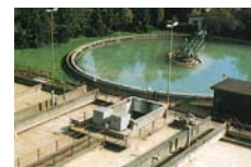
Последствия на очистных сооружениях
