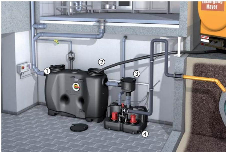
Жиροуделители серии *EasyClean G Basic* ① разработаны в соответствии со стандартом EN 1825-1. Жиροуделители серии *EasyClean G Basic* особенно отличаются в легкости установки и в простоте обслуживания.
